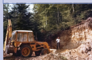
Der Einsatz von Baggern ermöglichte ab den 1970er Jahren das Erreichen tieferer Tonvorkommen.
