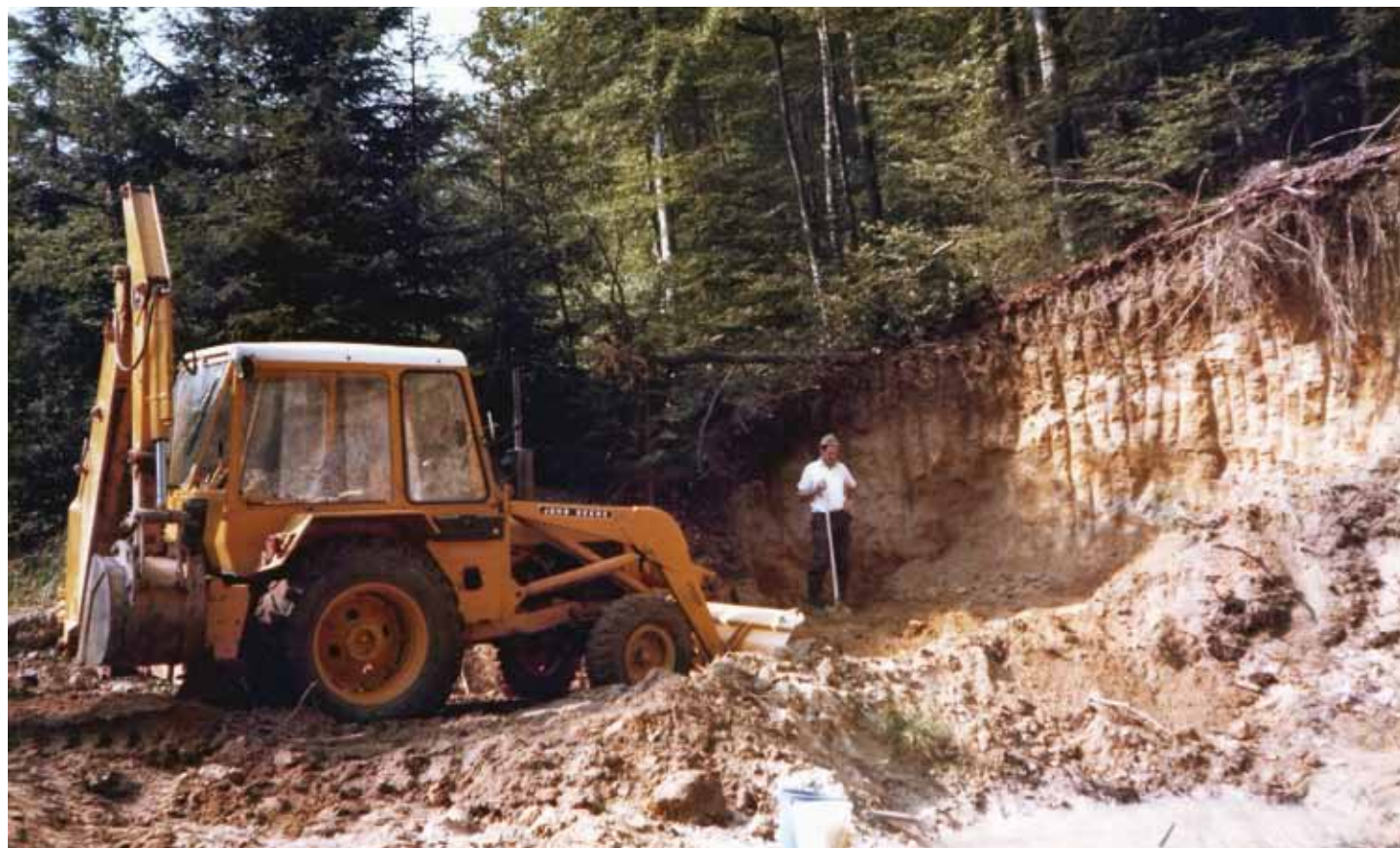
Abbau durch Handarbeit war um 1970 nicht mehr rentabel. Der Einsatz von Baggern ermöglichte das Erreichen tieferer Tonvorkommen.
